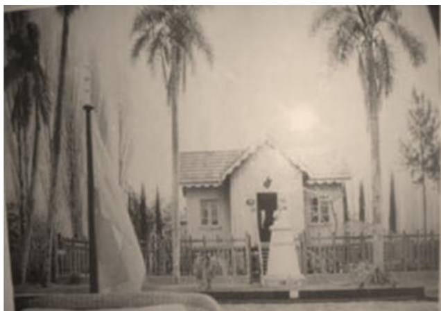
Casa de Domingo F. Sarmiento en el Delta. Imagen original previa a los trabajos de conservación
