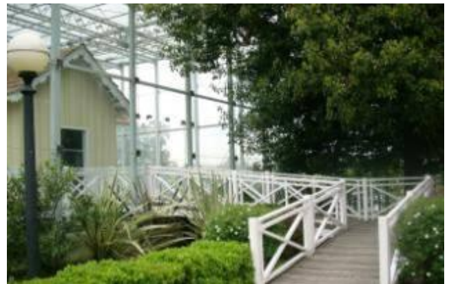
Casa de Domingo F. Sarmiento en el Delta. Vista actual con los trabajos correspondientes a la preservación por intemperismo
