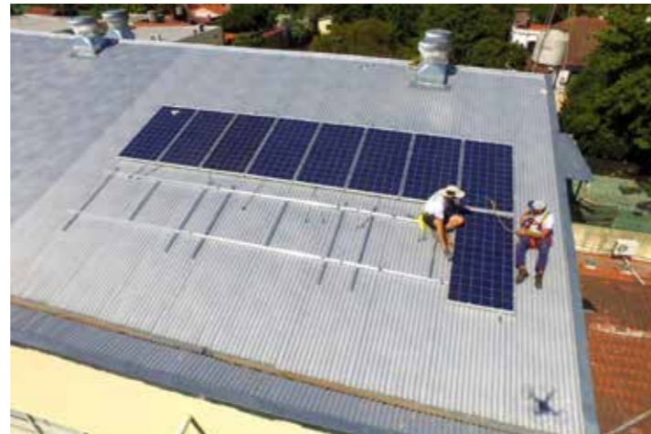
Figura 5: Montaje de los paneles.
