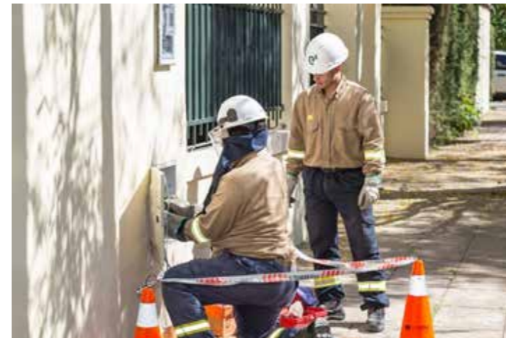
Figura 6: Instalación del segundo medidor.
